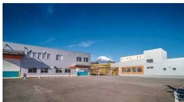
アポロ精工社屋全景
