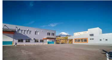
アポロ精工社屋全景
