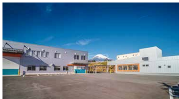
アポロ精工社屋全景
