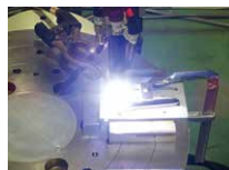
ロボット溶接
