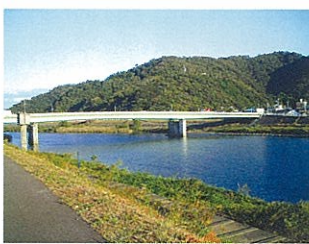
1 黒瀬橋と狩野川堤
