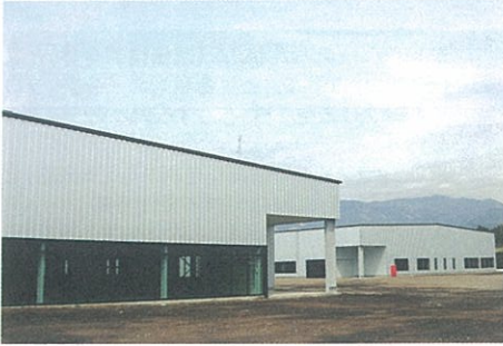
■会場の門池地区。急ピッチで整備が進む
