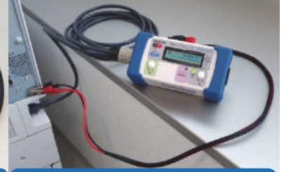
電源コードを取り外せない機器の接地抵抗診断
